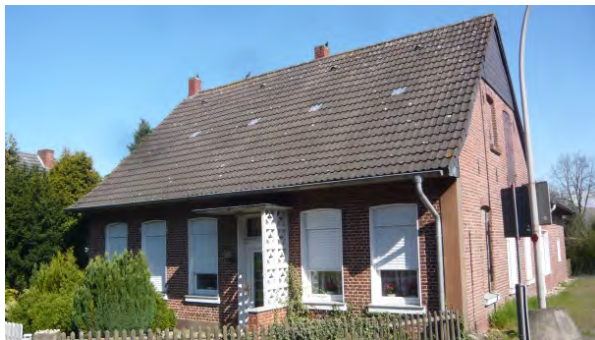
Wohngebäude Ochtruper Straße 1a
