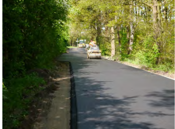
Sanierung des Schöppinger Damm
