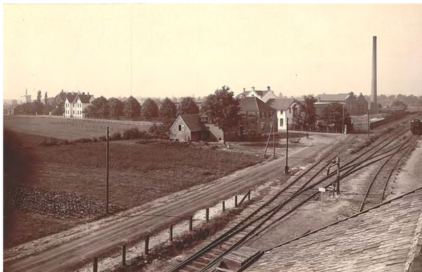
Gelände Westfälische Landeseisenbahn / Molkerei Borgers / Firma Schniewind (Repro: GA Heek)
