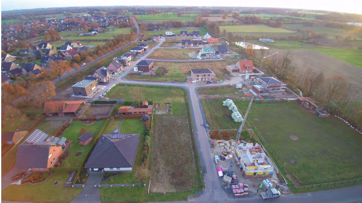
Hoher Baubetrieb bei rd. 20 Häusern im Baugebiet Strothbach (November 2016)
