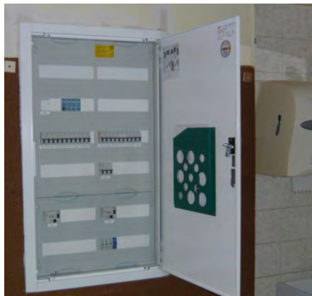
Erneuerung der Elektroverteilung
