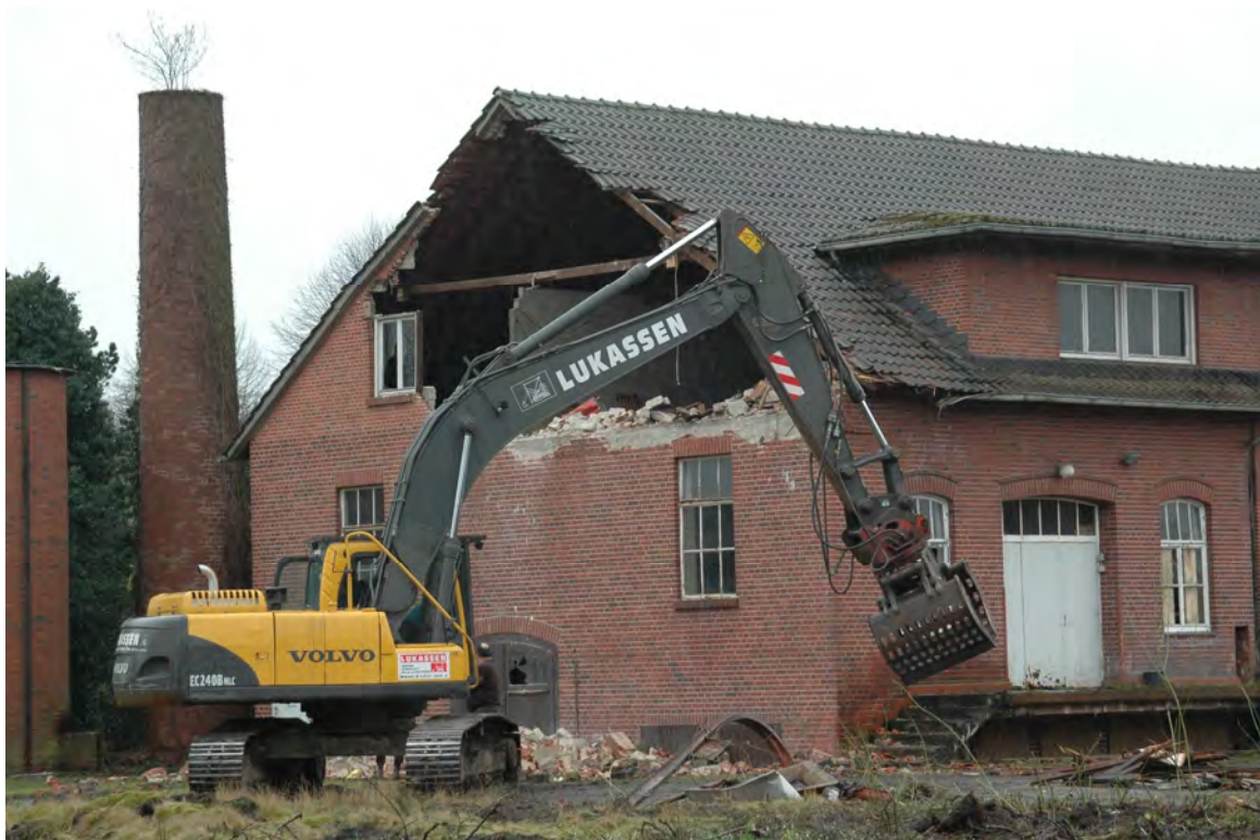
Abriss der Molkerei am 10.03.2009
