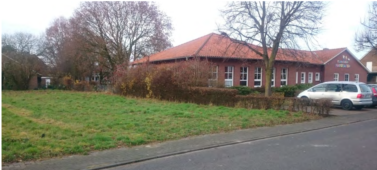
Erweiterung des St. Marien Kindergartens an der Grimmelstraße
