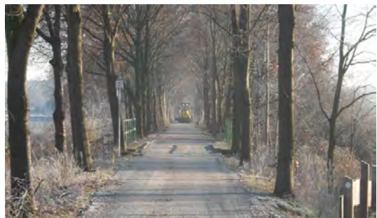
Sanierungsarbeiten am Bahndamm
