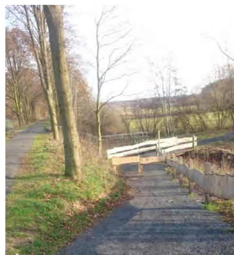
Provisorium am Bahndamm
