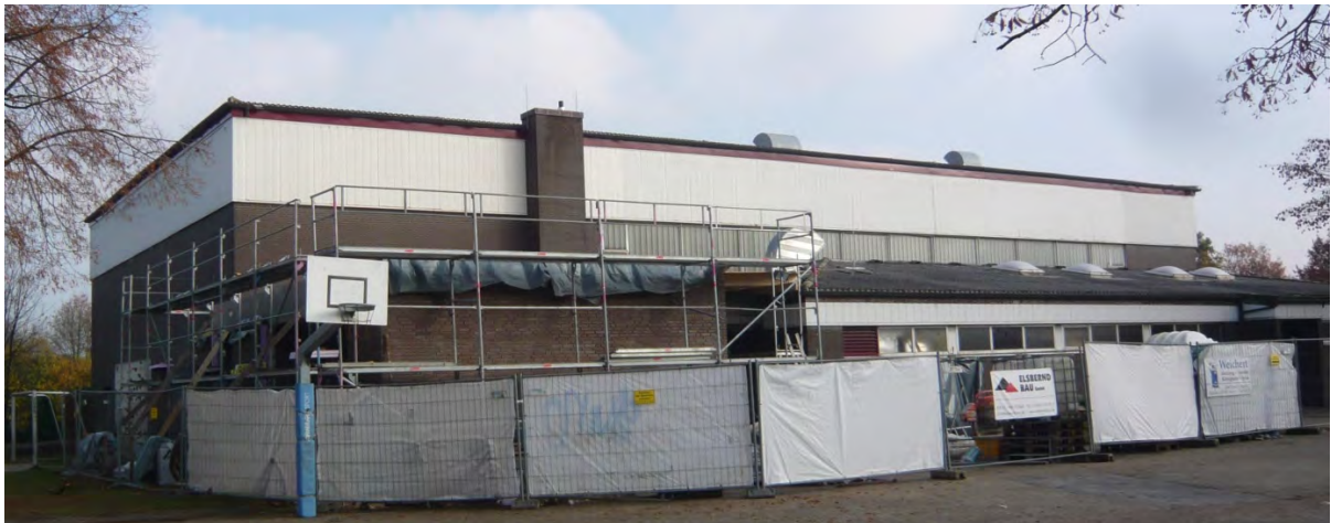
Erweiterung der Turnhalle an der Kreuzschule mit einem Klassen- und Differenzierungsraum
