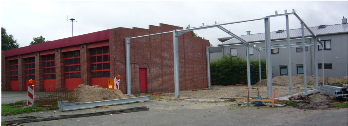
Errichtung der Stahlhalle
