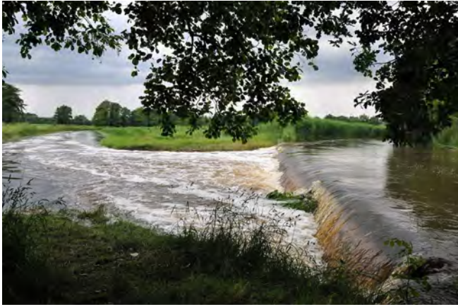
Überschwemmungen an der Umflut im Hagen
