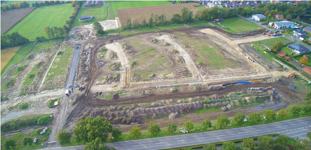
Erschließungsarbeiten am Baugebiet Strothbach
