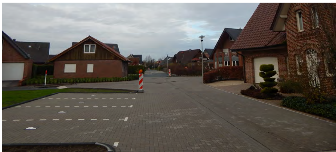
Impressionen vom Straßenendausbau der Straßen Am Waldrand und Zum Kreuzweg
