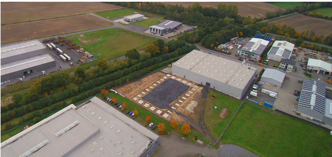
Erweiterung der Firma IBS Logistics in Heek-West
