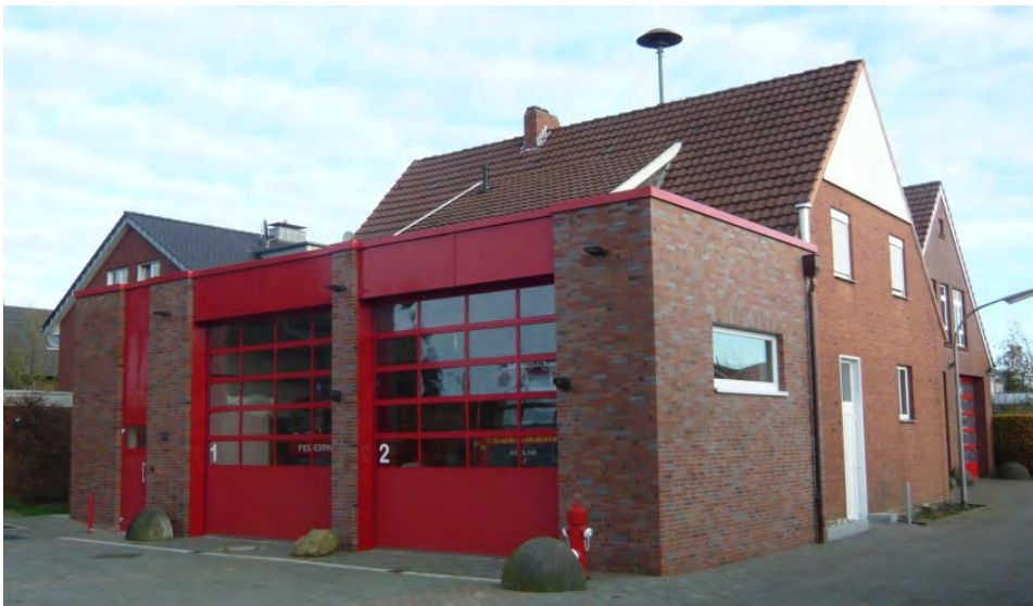
Erweiterung des Feuerwehrgerätehauses in Nienborg
