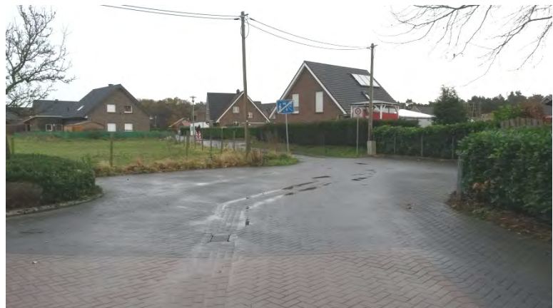
Dieser Bereich soll optimiert werden.
