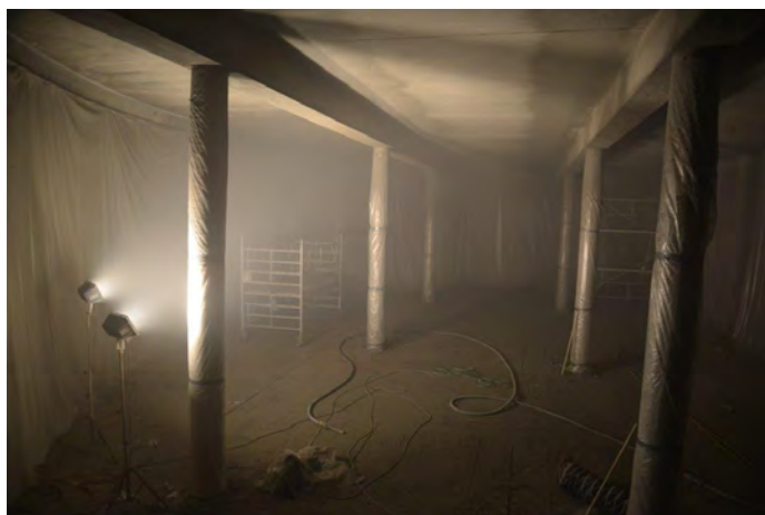
Sanierungsarbeiten am Trinkwasserspeicher
